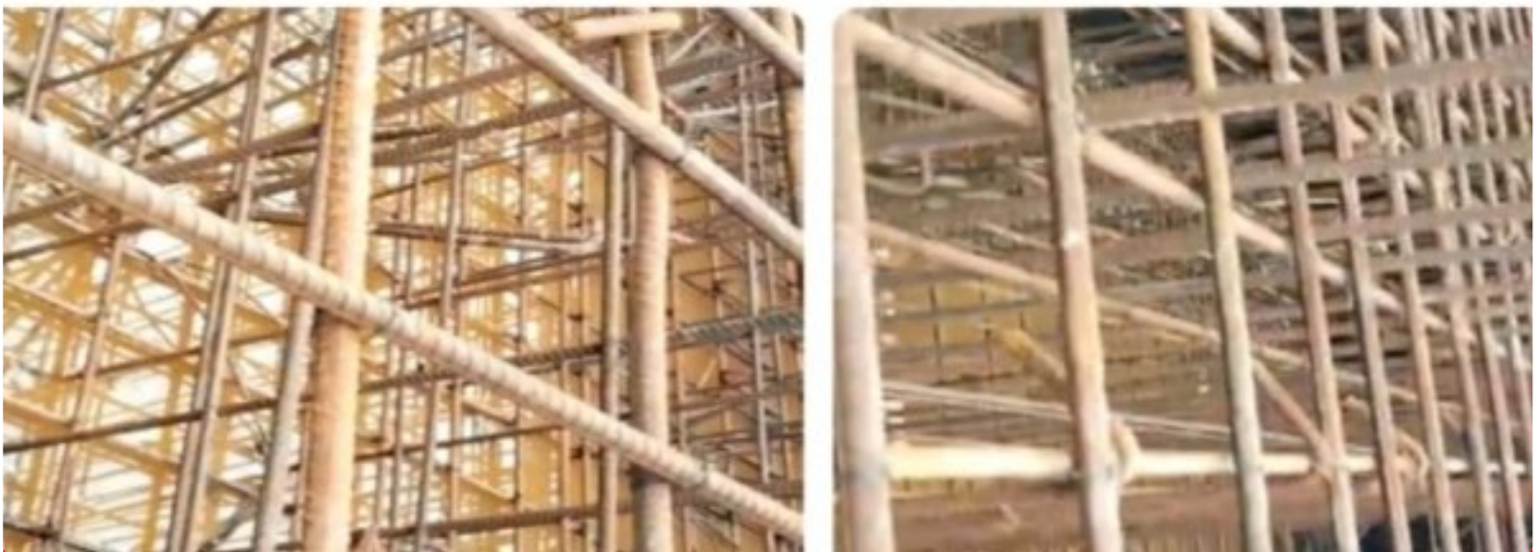
Proyek Jembatan Gantung
