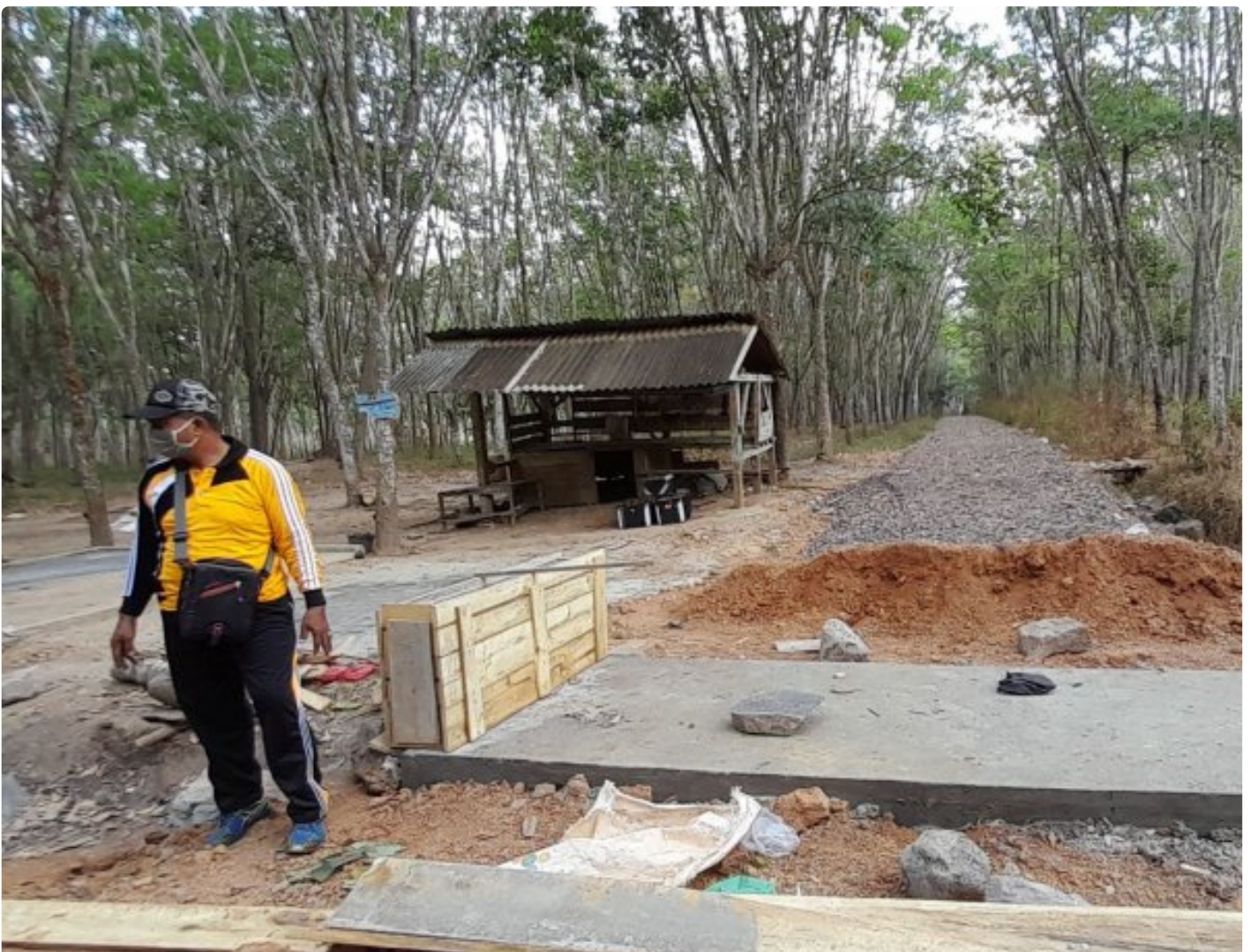
Kepala Desa Jaya Sakti Monitoring Pembangunan
